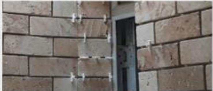
اسپیسر آجر و بلوک ( صلیب ) Spacer
